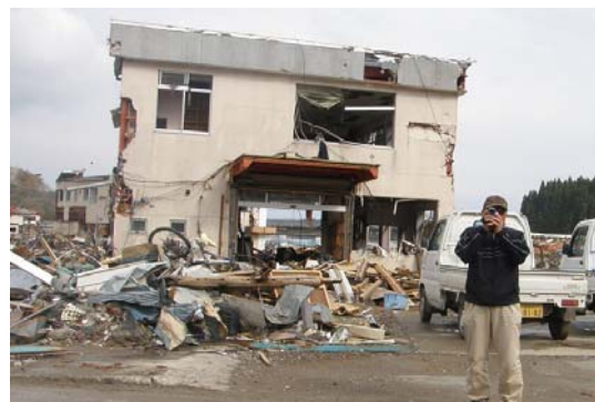
南三陸町の被害状況を調査する水沢
