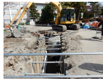
(文京) 屋外給排水配管改修 1.9億円
