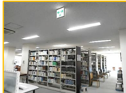
照明設備のLED化 (総合図書館3階閲覧室)
